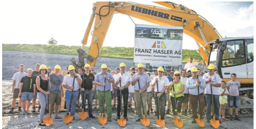
Peter Hasler (Bauherr), Gemeindevorsteher Donath Oehri und Helmut Hasler (Bauherr) umringt vom Gemeinderat von BERNEN-Gamprin beim Spatenstich. (Foto: Michael Zanghellini)
